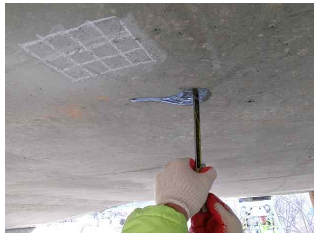
탄산화깊이 측정 현황
